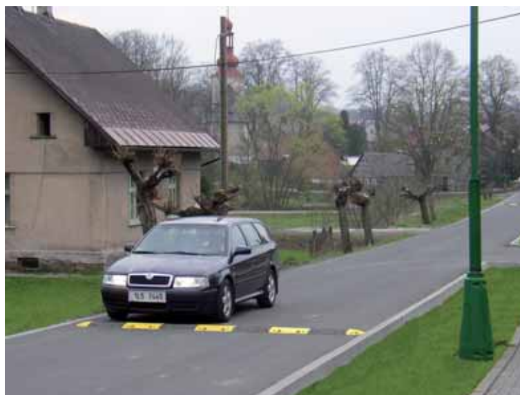
Obrázek 54: Našroubované umělohmotné prvky: nízká životnost; nepříjemné pro řidiče, nadměrný hluk, neestetický prvek (ČR)
