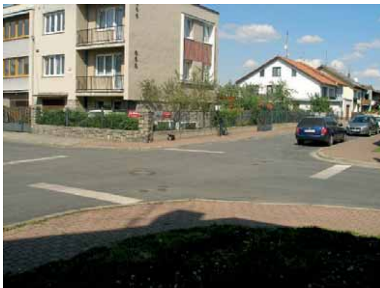
Obrázek 43: Příčné čáry souvislé jako připomínka povinnosti dát přednost v jízdě provozu přijíždějícímu zprava (ČR)
