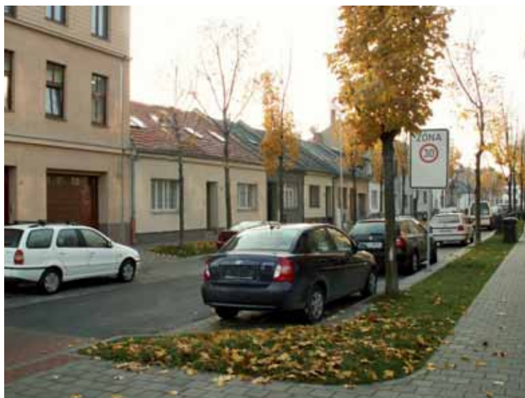
Obrázek 60: Vjezd do Zóny 30 s použitím zvýšené plochy, značka začátku Zóny posunuta cca 15 metrů od hlavní místní komunikace (ČR)
