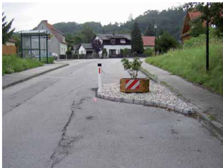
Obrázek 49: Dvoupruhové jednosměrné zúžení spojené s dlážděnou plochou; míjení vozidel je umožněno [6]
