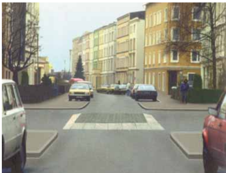
Obrázek 36: Zpomalovací polštář uvnitř křižovatky [29]
