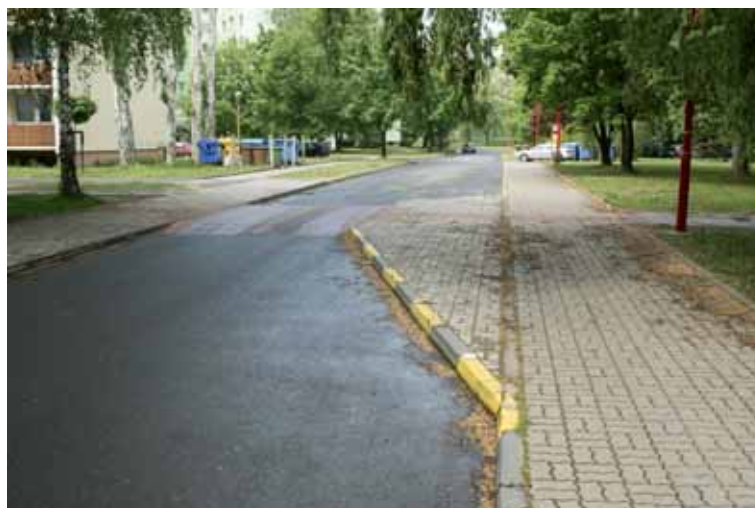
Obrázek 50: Dvoupruhové jednosměrné zúžení spojené s místem pro přecházení v Zóně 30 (ČR)
