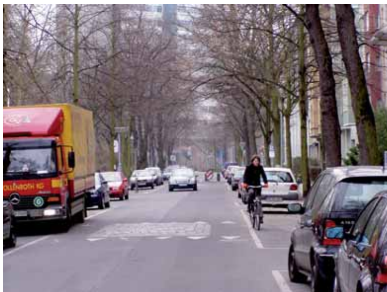
Obrázek 55: Zpomalovací polštář umožňuje cyklistům nerušenou jízdu (Německo)
