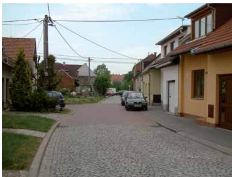
Obrázek 40: Zvýšená křižovatková plocha na stykové křižovatce (ČR)
