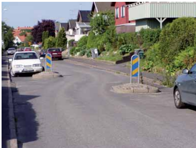
Obrázek 45: Střídavě vysazená plocha odsazená od obrubníku (Švédsko)
