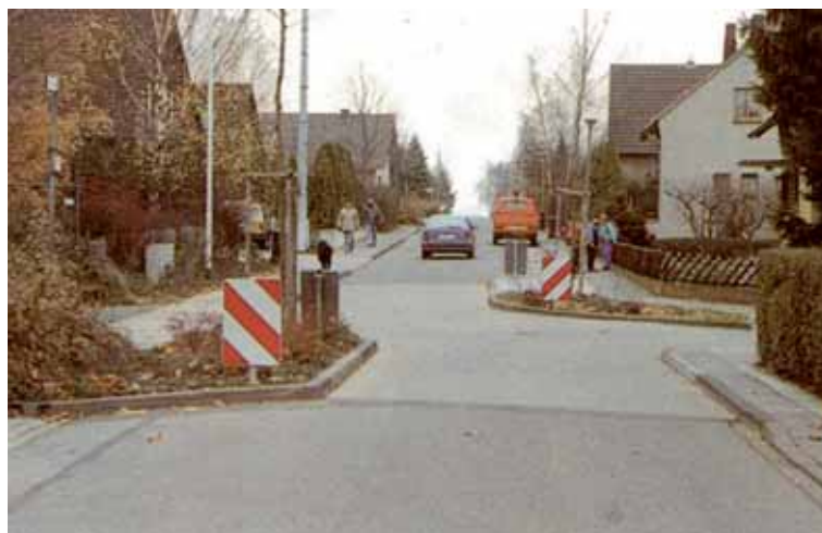
Obrázek 35: Řešení s vysazenými plochami tvořícími střídavě obousměrné zúžení na stykové křižovatce. [6]
