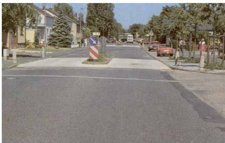
Obrázek 57: Dlouhý zpomalovací práh s dělicím ostrůvkem [6]
