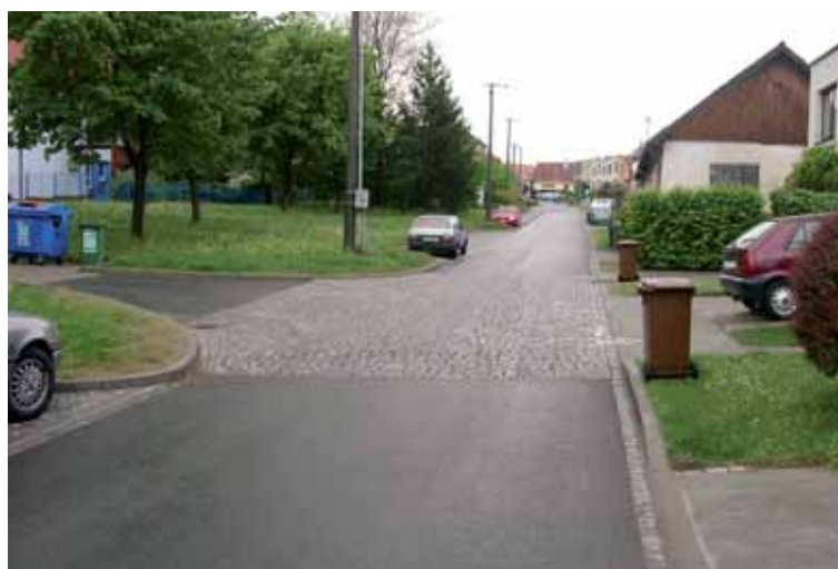
Obrázek 42: Dlažděná styková křižovatka místních komunikací (ČR)
