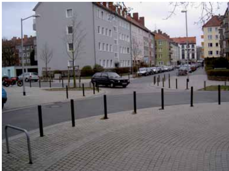
Obrázek 41: Křižovatka s chodníkovým přejezdem – tzv. diagonální uzávěra (Německo)
