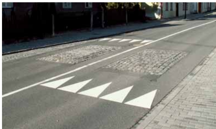
Obrázek 56: Dvojice zpomalovacích polštářů (ČR)
