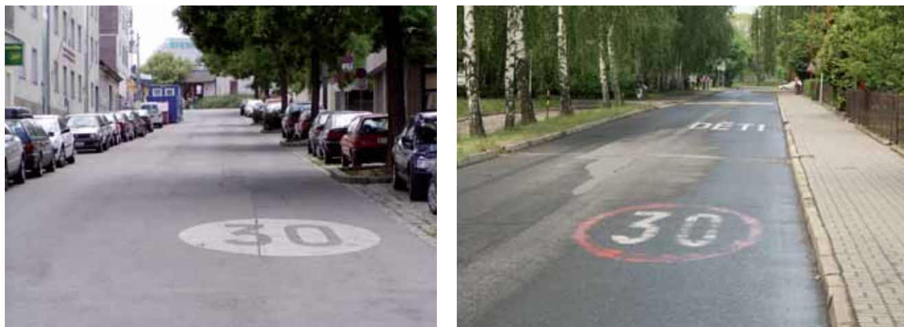
Obrázek 16: Zdůraznění plošného omezení rychlosti vodorovným značením na vozovce (vlevo příklad z Rakouska, vpravo ČR)
