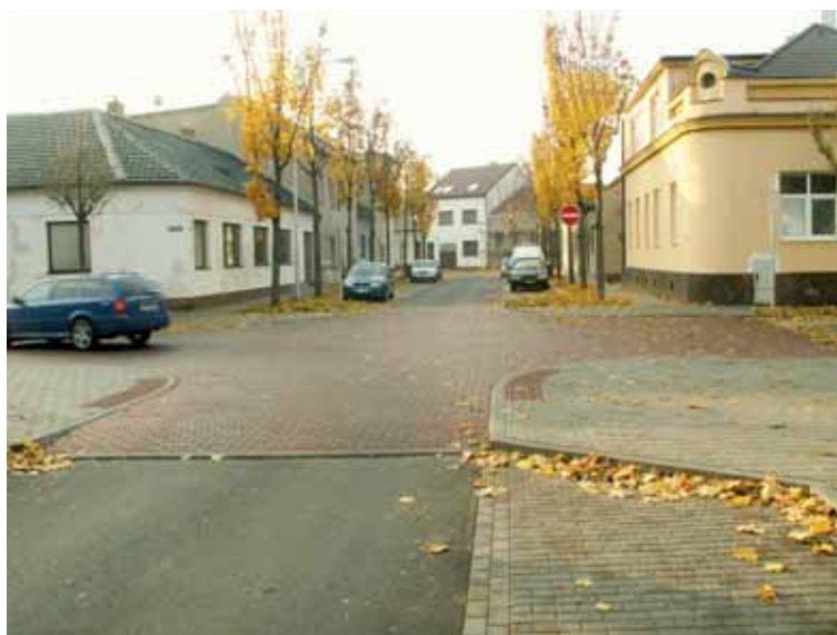
Obrázek 38: Zvýšená křižovatková plocha provedená barevnými betonovými dlaždicemi v kombinaci s vysazenými chodníkovými plochami (ČR).
