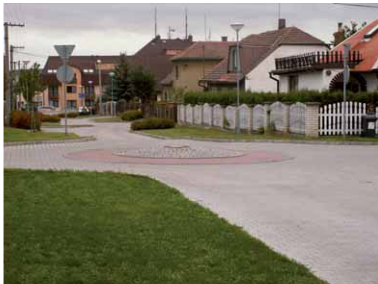
Obrázek 44: Miniokružní křižovatka se středovým ostrůvkem redukováným na dlážděnou pojezděnou plochu (ČR)
