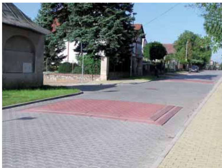
Obrázek 37: Nápadně provedené zpomalovací polštáře umístěné před stykovou křižovatkou a za ní (ČR)
