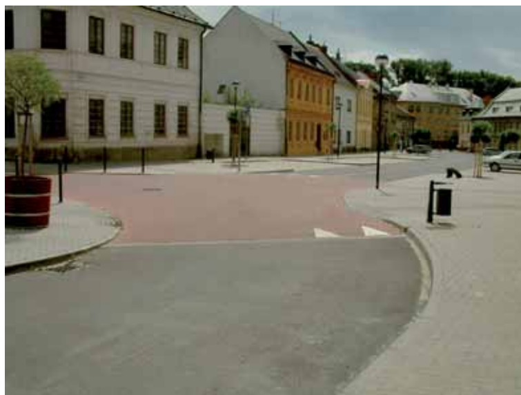
Obrázek 39: Zvýšená křižovatková plocha na stykové křižovatce (ČR)
