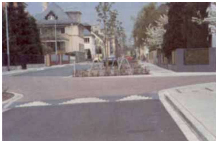
Obrázek 34: Řešení s vysazenou plochou a střídavě uspořádaným parkovacím stáním se záhony a stromy na křižovatce s vyvýšenou plochou. [6]
