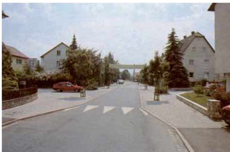
Obrázek 51: Delší oboustranné zúžení [6]
