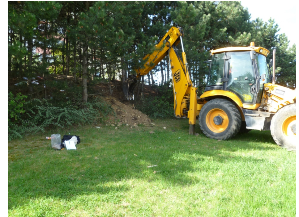
Foto č. 6. Realizace sondy K 3
